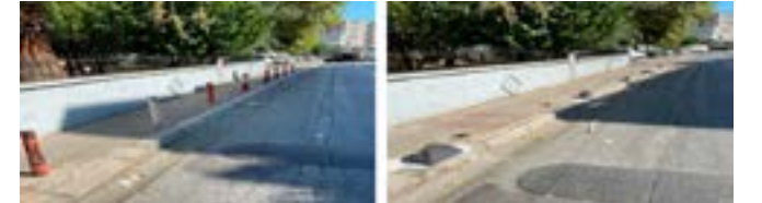
Küçükada Mahallesi 3555/1 Sokak No: 16 Adresindeki Tehlikeli Duvara Emniyet Şeridi Çekilmesi ve Uyarı Levhası Montaj İşi
