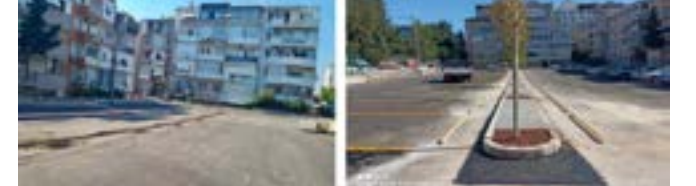
Çahabey Mahallesi Halitbey İlkokulu Bahçesinde Korkuluk İmalat ve Montaj İşi
