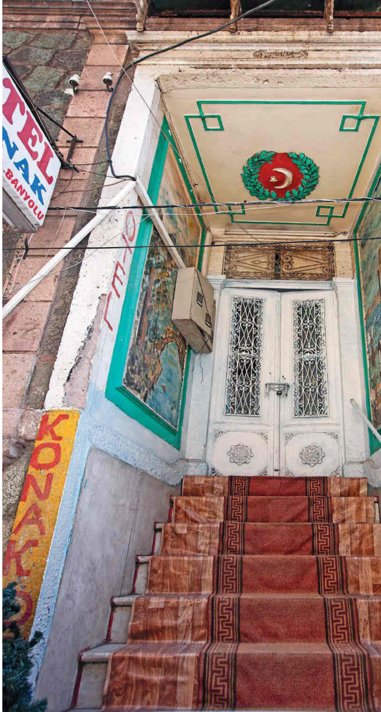
Akinci Mahallesi 945 Sokak No: 15 Fotoğraf: Atilla ÖZDEMİR
