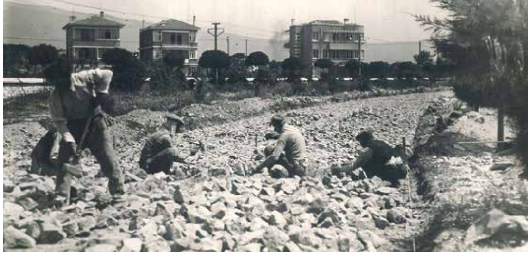
kültürpark bisiklet yolu yapım çalışmaları
