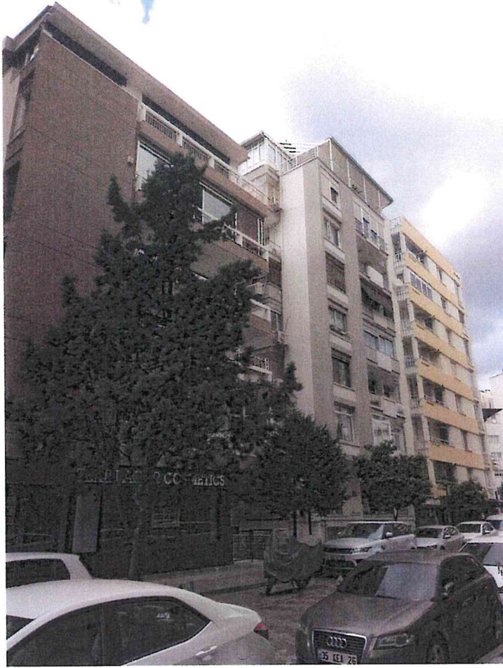
Şekil 7. 1383 Sokak Cephe Görüntüsü
