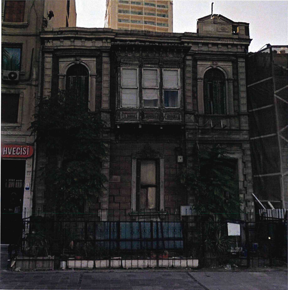
Görsel 39: 1215 Ada 3 Parsel üzerindeki tescilli yapı
