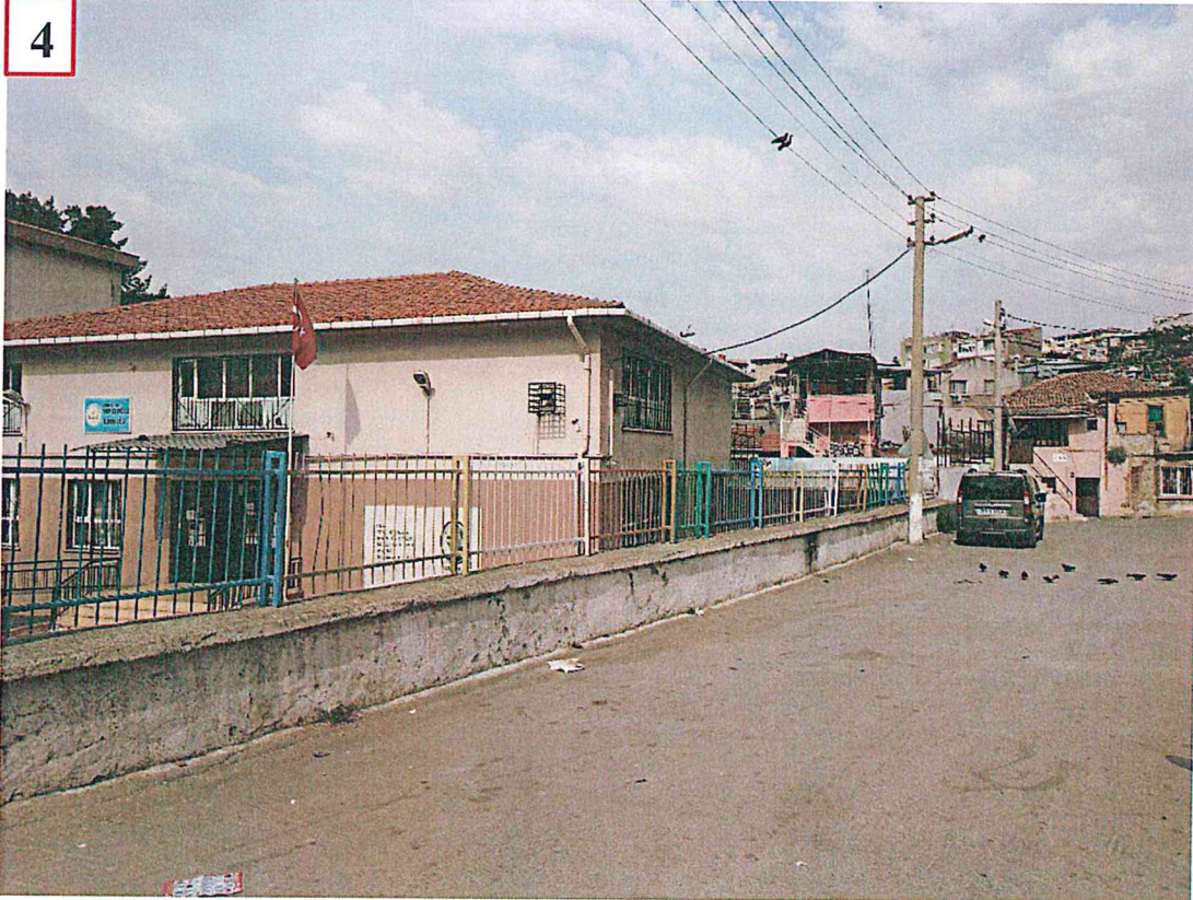
Fotoğraf 4: 676 Sokaktan Yapıcıoğlu İlkokuluna bakış.
