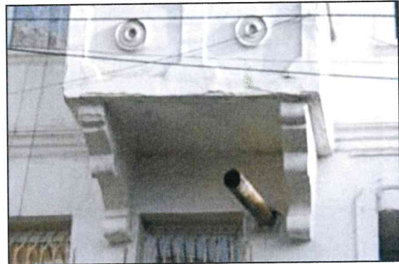
Şekil 24 a-b-c-d: Cumba altlarında kullanılan dökme demir, profil demir ve betonarme konsol örnekleri
