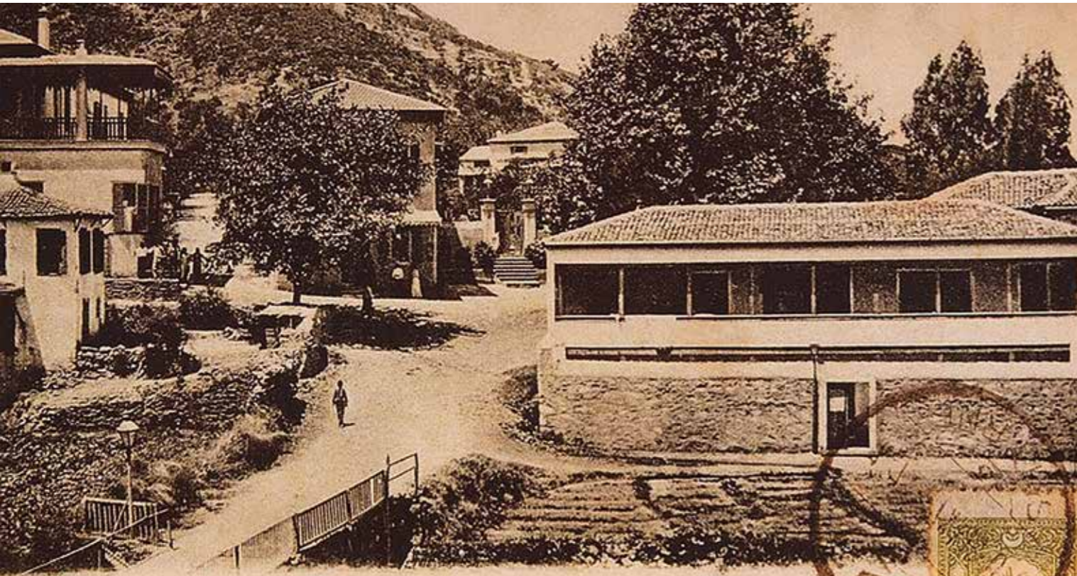
Etage superieur des bains d'Agamemnon
